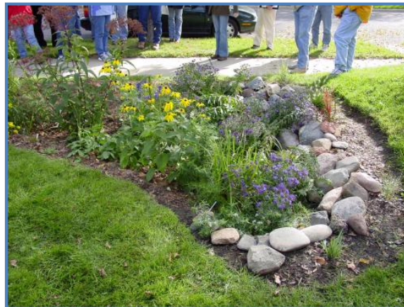
Bioretention (Rain Garden)
