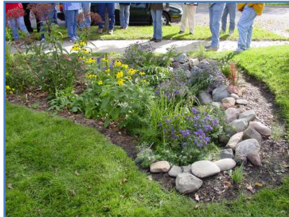
Bioretention (Rain Garden)
